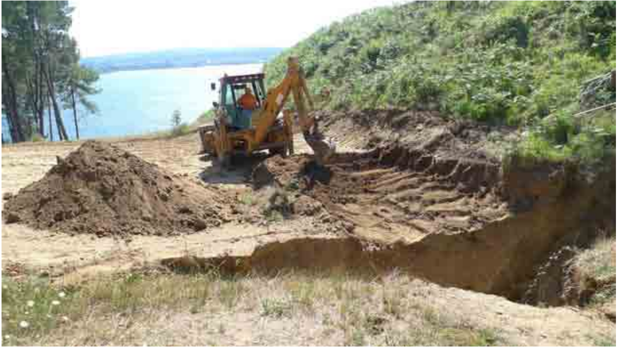
Decapaxe dos recheos superficiais no trazado do foxo
